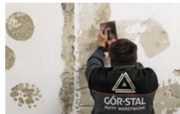
Etap I. Mechaniczne usunięcie pozostałości starych tynków i klei oraz złuszczającej się farby.
