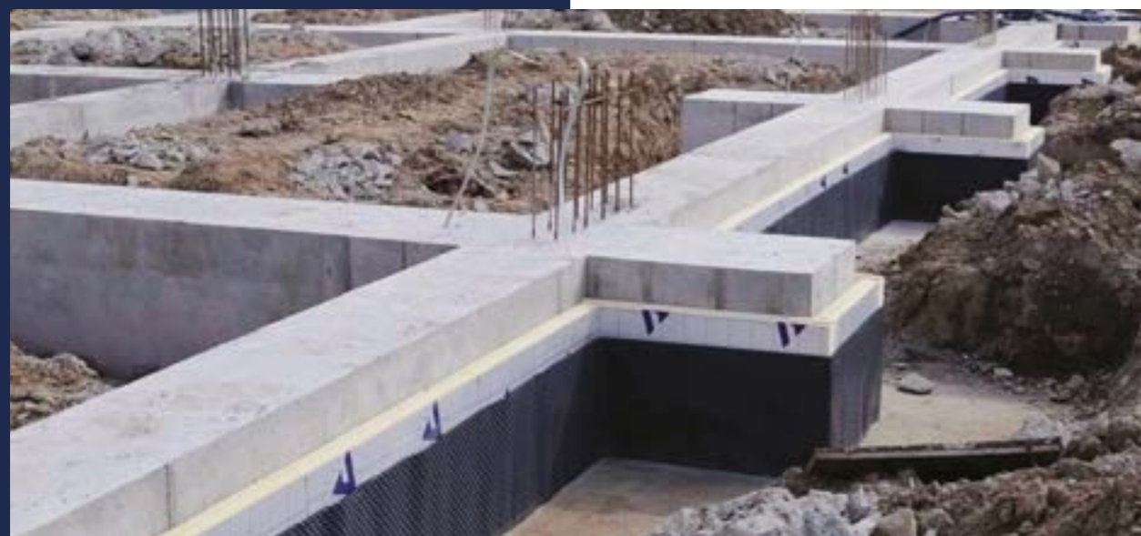
Ocieplenie fundamentów płytami termPIR®
