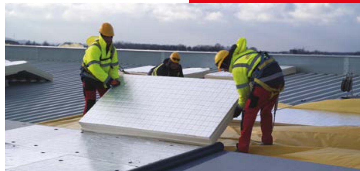
Montaż płyt IZOPROOF® na dachu płaskim
