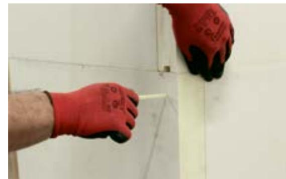
e) Installazione dei connettori in plastica che proteggono l'angolo dalla deformazione.
