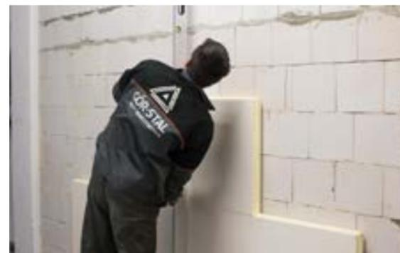
FASE III a) Montaggio e posizionamento della seconda fila di pannelli.
