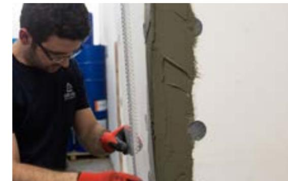
FASE V c) Montaggio dell'elemento angolare pronto per l'uso.
