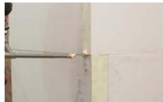
f) Riempimento delle convessità con schiuma poliuretana a bassa espansione.
