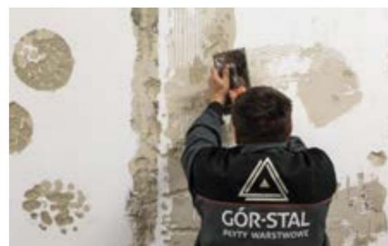
FASE I. Rimozione meccanica di vecchi residui di intonaco e colla e di pittura scrostate.
