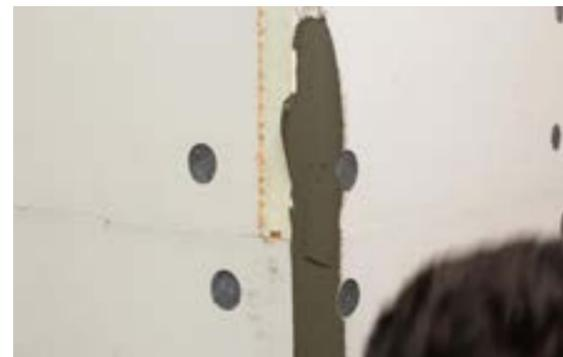
FASE V b) Posizionamento dello strato adesivo nell'angolo.
