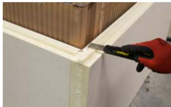
d) Rimozione della linguetta del pannello angolare.
