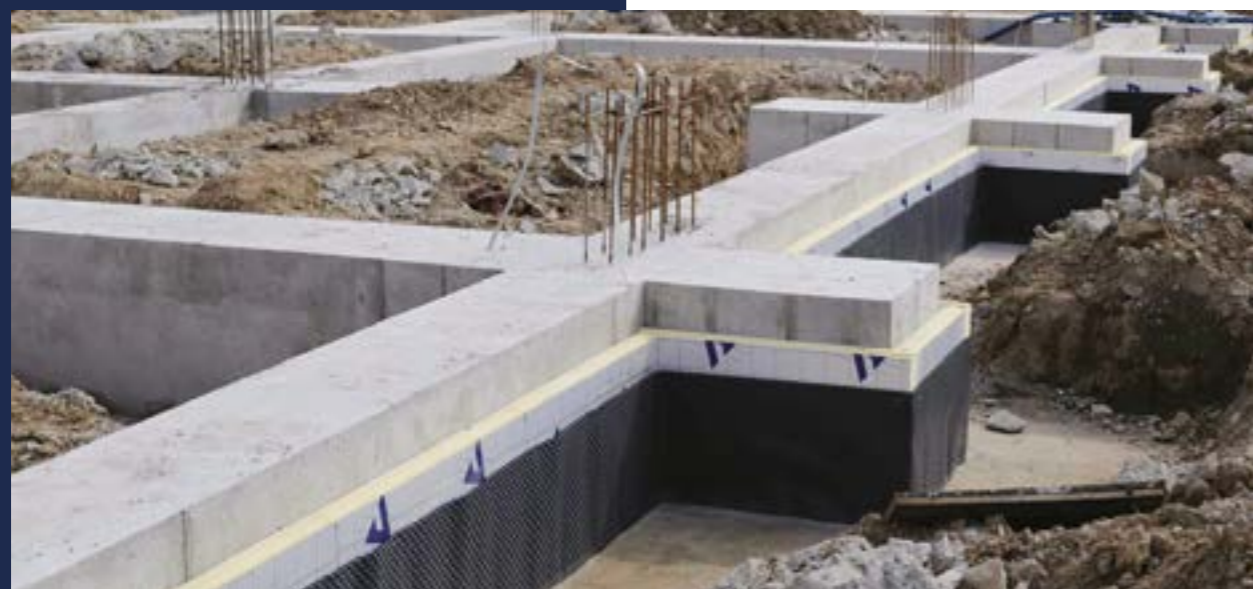
Installazione dei pannelli termPIR® su un pavimenti
