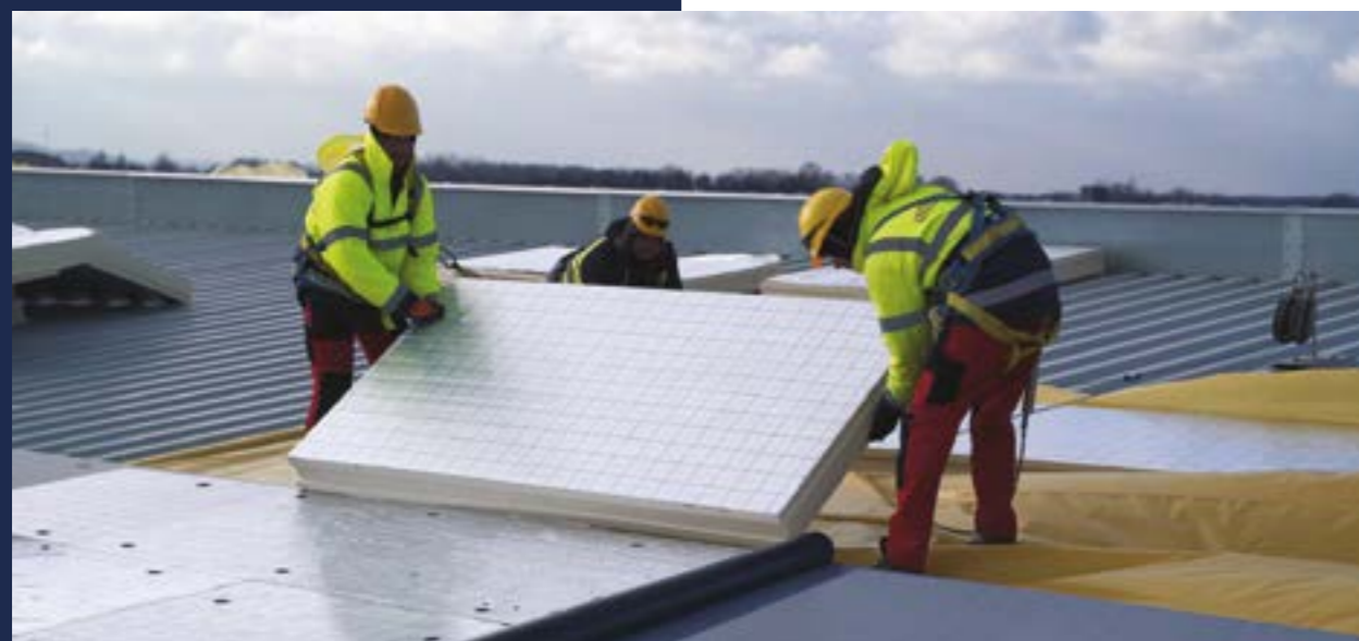
Installazione dei pannelli termPIR® su un tetto piano
