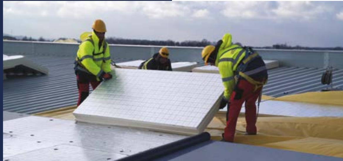
Montage von termPIR®-Platten auf einem Flachdach
