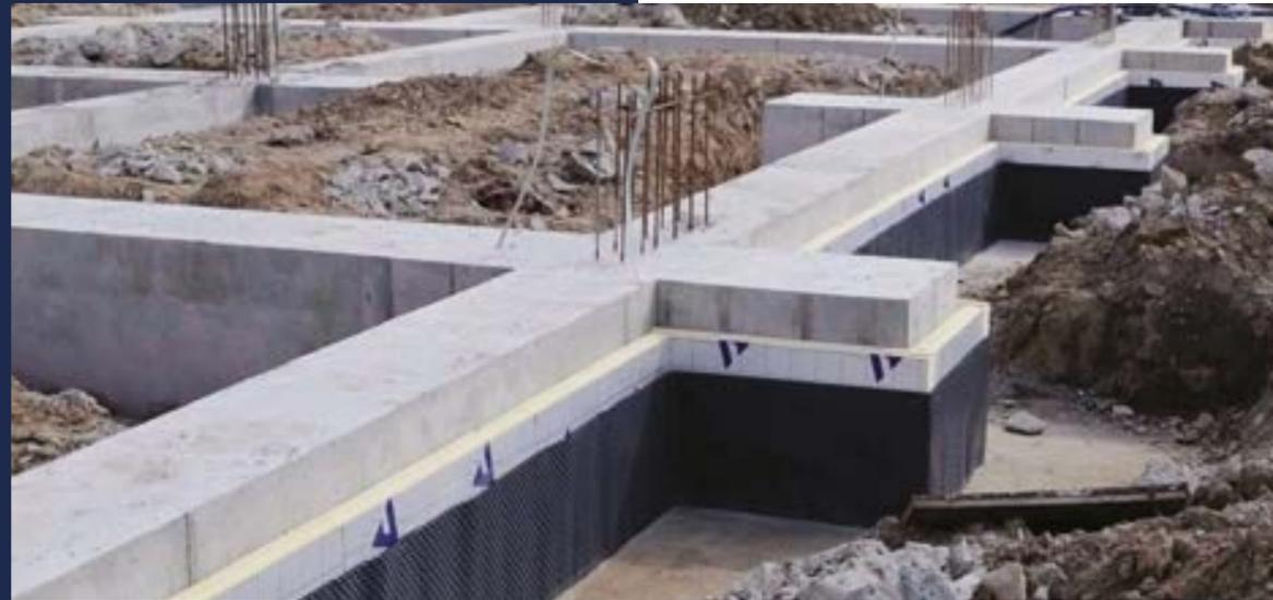
Isolierung von Fundaments mit termPIR®-Boards
